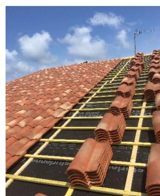
**8/ Mise en place du faitage, des tuiles à douilles, fixation des tuiles de rive y compris les bas de pente.**
