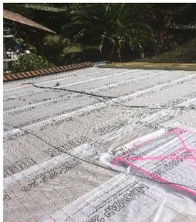
Nous pouvons voir sur les photos, tout le câblage électrique repris dans l'épaisseur de l'isolation sous la tuile
